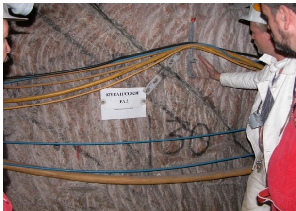
Рис. 46. Датчики смещений по трещинам в соляных формациях хранилища РАО «Горлебен» (Германия)
